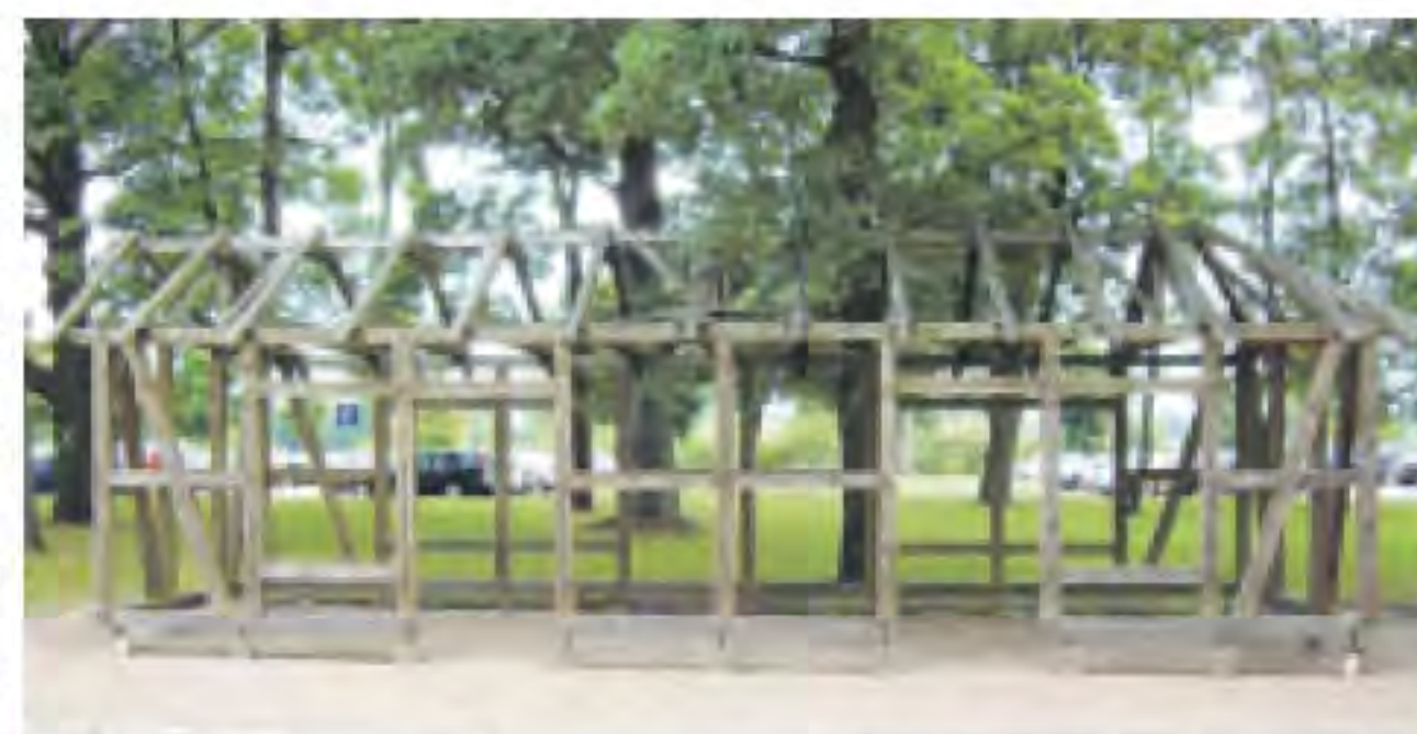
Das Bauwerk soll als Anschauungs- und Übungsobjekt für die Ausbildung dienen.
